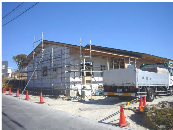
旧愛光園跡地（大府市）に建築中のケアホーム
