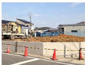
増築工事が進行中 春には完成予定
